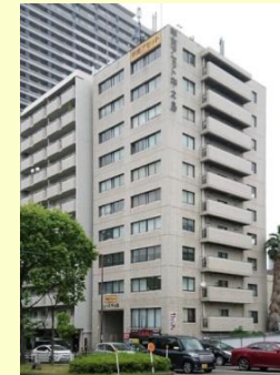
大阪中之島ビル (中之島 ナニワ筋沿い)
