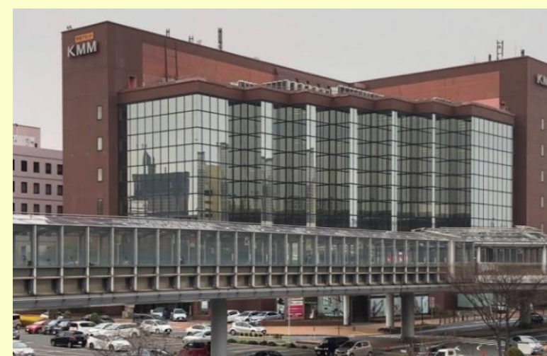
本館 (新幹線小倉駅直結)
