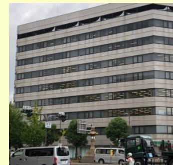
ファース堺ビル (元 AIG損保ビル)
