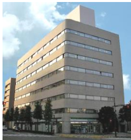
Sazan Mito Bldg.
